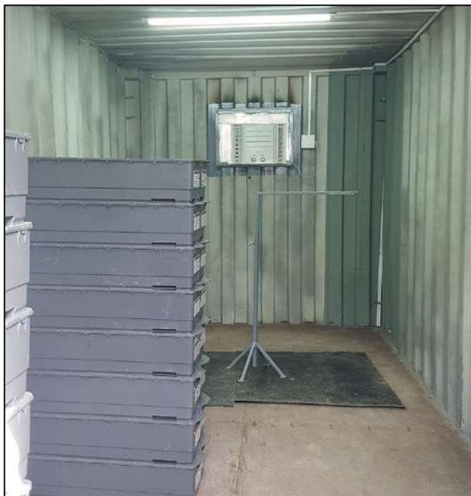
Figura 17: Contêiner com ar-condicionado para o armazenamento das rochas evaporíticas em canteiro de sondagem.
